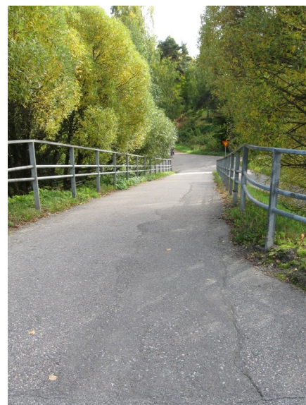
Reittikuva 11. Kuva Lohikoskentieltä Niskakujalle. Luiskan alapäässä on hankala viiden väylän risteys.
