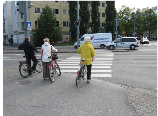
Reittikuva 3. Osuuden alkupiste Puistokadun ja Kalevankadun risteyksessä. Risteyksessä on turhan jyrkät reunakiveykset. Pyörätielinjausta voisi myös siirtää metrin verran oikealle.
