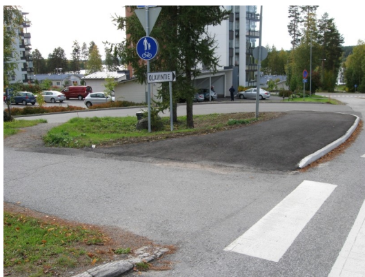
Reittikuva 25. Olavintien huonosti toteutettu pyörätie.
