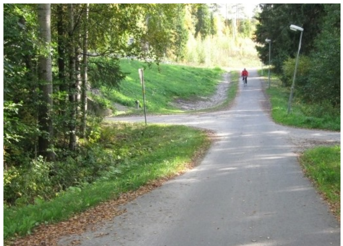
Reittikuva 20. Tunneliristeys Palokan suunnasta. Puut peittävät tunnelin suuaukon lähes täysin. Oikealla väylä Rantakukantielle.
