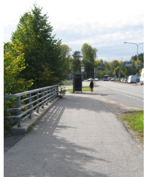
Reittikuva 12. Kaide, rehottava puu, bussipysäkki ja mutka aiheuttavat Lohikoskentielle vaarallisen näkemäesteen.
