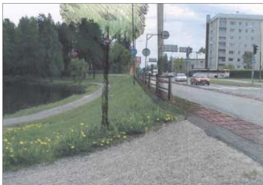
Kuva 33. Länsi-Päijänteentien liittymässä korostetaan laatukäytävää kiveyksin ja uusin kaitein.
