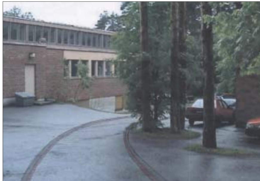
Kuva 37. Vaihtoehtoisen reitin epäjatkuvuuskohtia voidaan selkeyttää kiveyksin.
