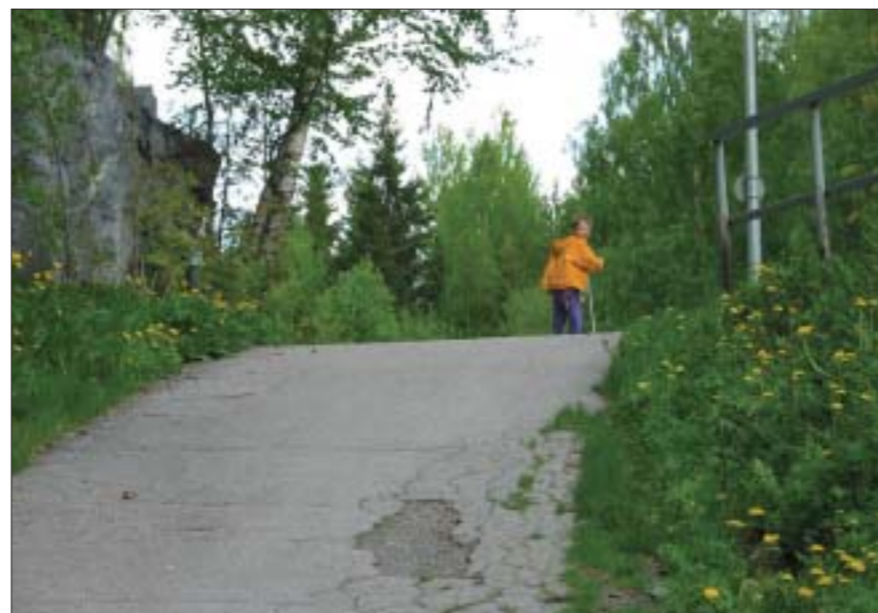
Kuva 10. Päällysteen epätasaisuus haittaa monin paikoin väylien käyttäjiä.
