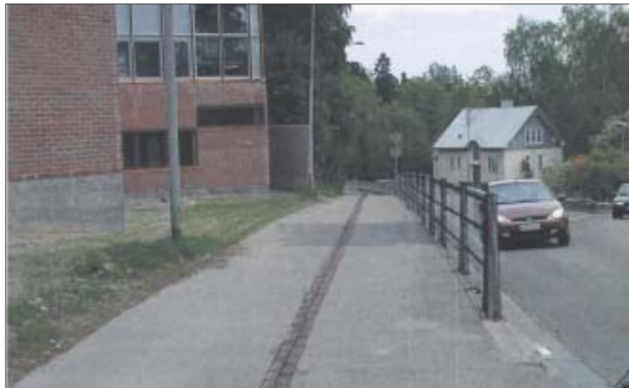
Kuva 30. Kiveyksellä eroteltavaa väylää Keskussairaalantien itäpäässä.
