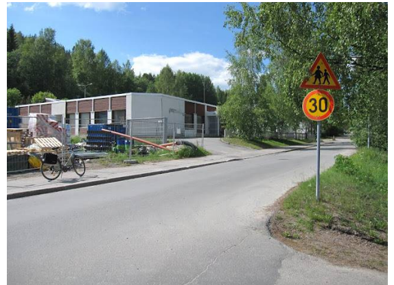
Pehtorintien alussa näkyy korkea ja madallettu reunakivi. Molemmat aiheuttavat kulkemisongelmia vanhuksille, pyörätuolilla liikkuville, lastenvaunuja työntäville sekä pyöräilijöille.
