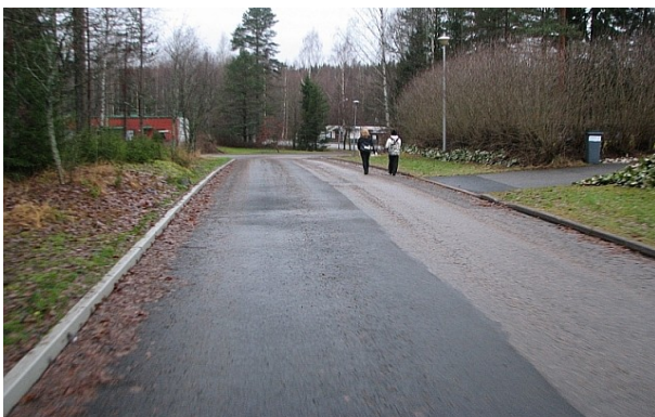
Reittikuva 61. Valmuskantiellä ei ole kevytväylää eikä jalkakäytävää. Pyöräkaistat kadulle mahtuisivat.
