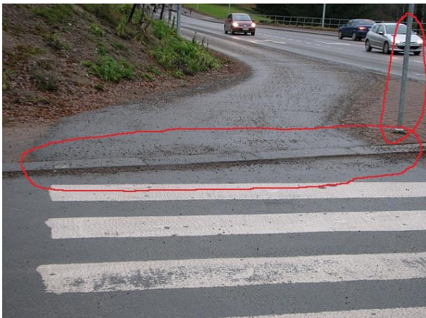
Reittikuva 30. Valajankadun risteysen terävä reunatuki. Reunatuki jysäyttää ikävästi renkaaseen ja vanteeseen sekä käsille. Oikeassa reunassa liikennemerkkitolppa kaventaa käytettävissä olevaa kulkuväylää.
