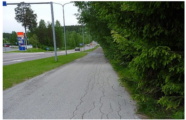
Reittikuva 43. Puut ja pensaat muodostavat näkemä- ja esteongelmaa lähes koko osuudella. Asfaltti on railoista.
