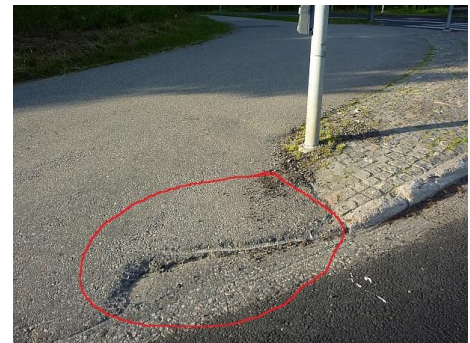
Reittikuva 37. Keskussairaalantien ylityksessä suojatien laidassa on terävä reunus.
