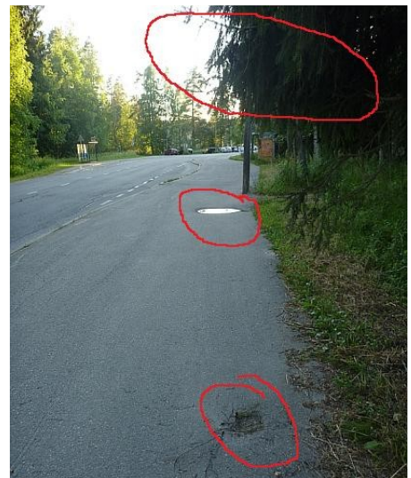
Reittikuva 81. Ongelmia osuuden lopussa: pieni ja iso monttu sekä osin kevytväylän puolella kasvava kuusi.
