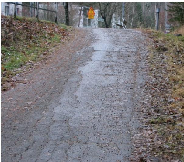
Reittikuva 55. Keltinmäentielle nousevan luiskan asfaltti on todella huonossa kunnossa.
