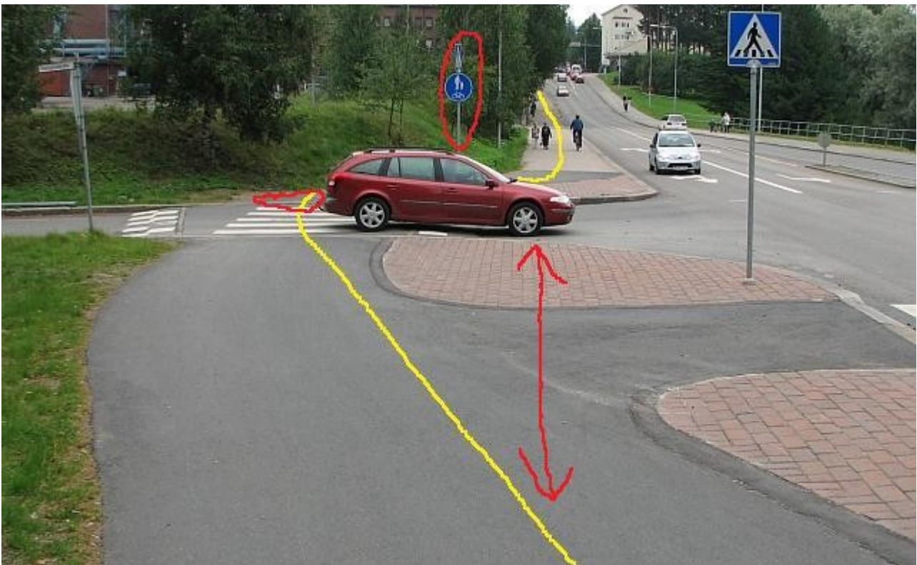
Reittikuva 28. Valajankadun risteys Kyllönmäen suunnasta katsottuna. Auto on pysähtynyt risteykseen juuri siten, miten ei pitäisi, eli puoliksi suojatien päälle. Terävä reunakiveys ja liikennemerkkitolppa ajolinjalla on ympyröity. Mutkittelevan ajolinjan vuoksi monet pyöräilevät talvisin punaisella merkittyä suoraa reittiä pitkin. Maavalli ja puut aiheuttavat risteyksessä näkemäongelmaa.
