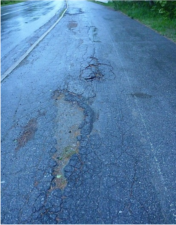
Pinta- ja rakenneaurioita Erämiehenkadulla Varpukadun ja Saihokadun välillä.
