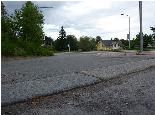
Melko matala mutta reunaltaan todella terävä reunakivi Valajankadun risteyksessä. Tällaisen nähdessään pyöräilijän katse keskittyy matalimman ja loivimman ajolinjan etsintään.
