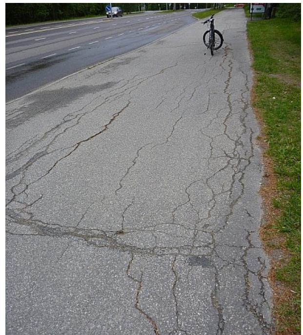
Railoista ja epätasaista asfalttia Keskussairaalantiellä Kyllön terveysaseman vieressä.
