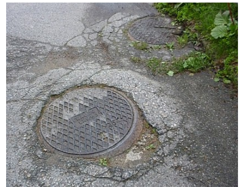
Reittikuva 56. Osuuden lopussa on kaikkiaan kolme tällaista kaivonkannen ympärystä. Kannet on nykyisellään pakko kiertää.
