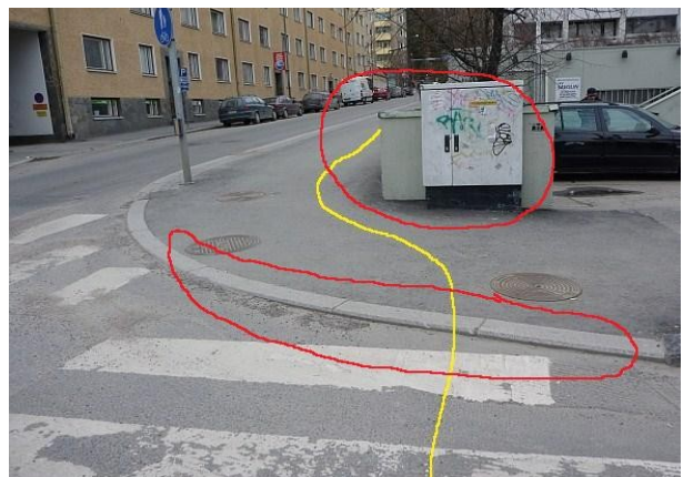
Cygnaeuksenkadun kevytväyläliittymän ongelmia: terävä faasireunakiveys, näkemä- ja esteongelmaa sekä mutkitteleva ajolinja.
