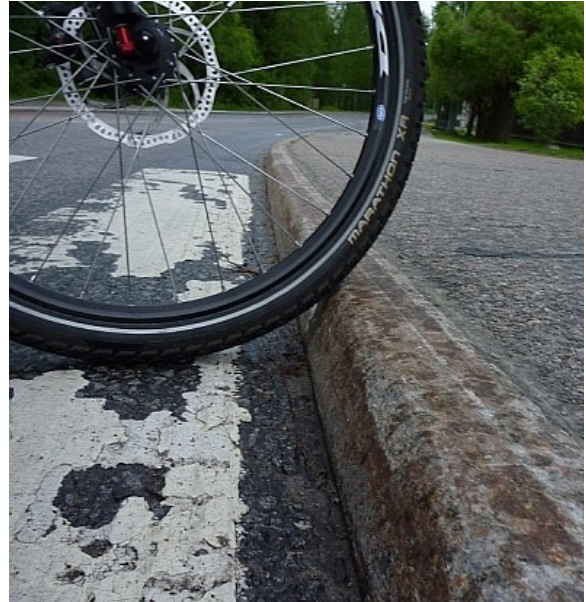
Todella korkea pystysuora reunatuki Orakkaantien liittymässä. Kiveys onneksi madaltui kesän aikana, kun ajorata asfaltoitiin uudelleen.
