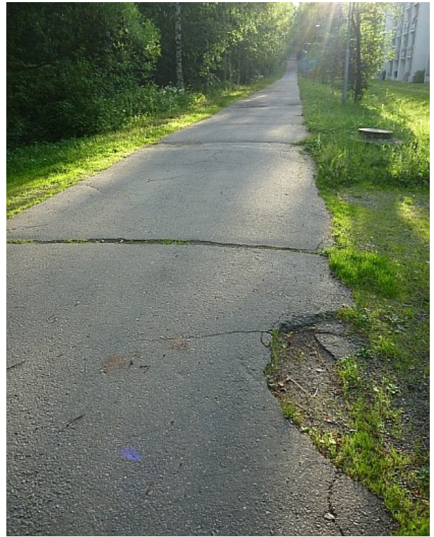
Pinta- ja rakenneaurioita Jussinparralla Haperontien sivustalla.
