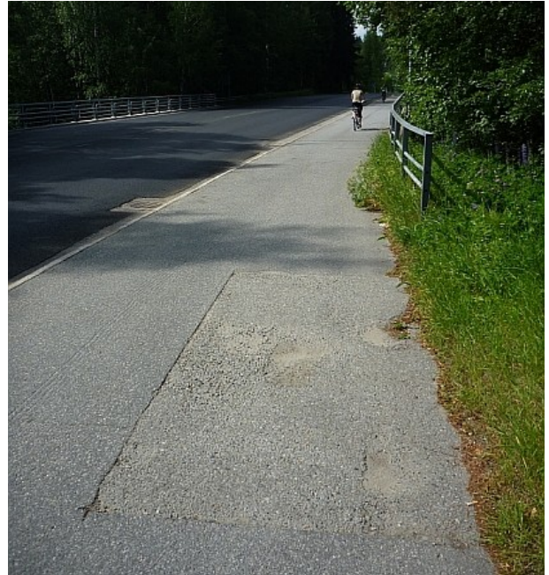
Reittikuva 72. Kuvan alalaidassa epätasainen paikkaus. Kauempana aivan kaiteen vieressä on monttuja. Väylä on kuitenkin pääosin suora ja profiiltaan tasainen.
