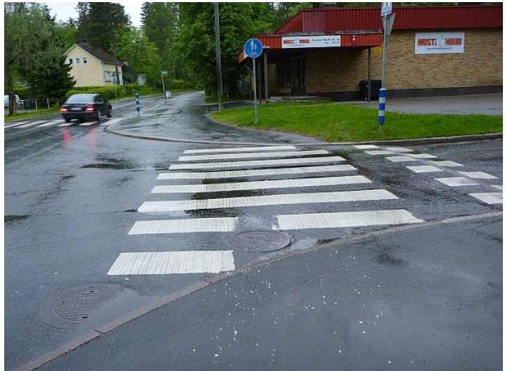
Keihäsmiehenkadun risteyksessä on terävät reunatuet. Risteuksen kohdalla pitää myös tehdä pieni mutka.
