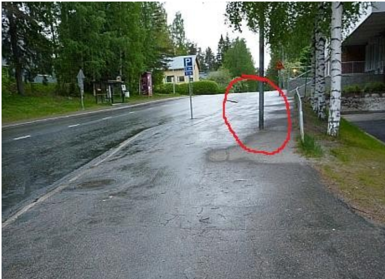
Reittikuva 77. Vaarallinen harmaa valaisintolppa osuuden alussa keskellä kevytväylää. Jos tolppaa ei voi siirtää, se on pikaisesti merkittävä kirkasvärillä huomioteipillä.
