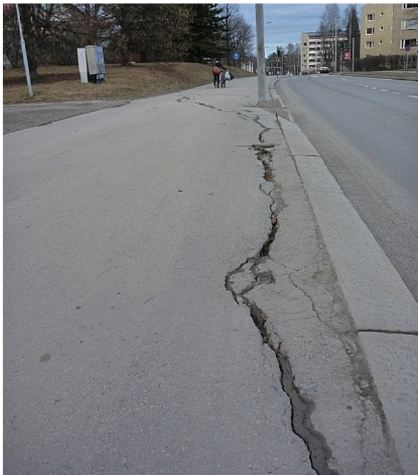
Vaarallinen railo Keskussairaalantiellä Köyhälammen vieressä.
