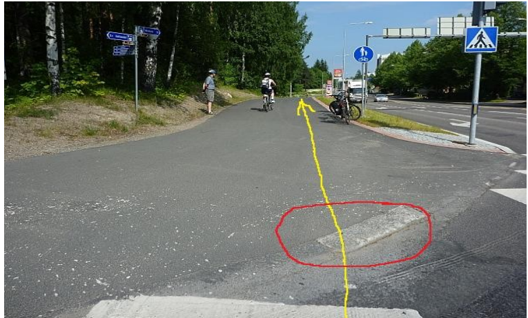
Reittikuva 24. Rautpohjankadun risteyksessä ajolinjalla on vaarallinen pystysuoran reunakiveyksen pätkä. Taustalla erottuu myös kevytväylän mäennypylä – viereinen autotie on profiililtaan selvästi tasaisempi.
