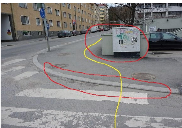
Reittikuva 9. Cygnaeuksenkadun ja Kauppakadun risteys. Kulmauksessa erottuu useita pyöräilyolosuhteiden haasteita: terävä reunatuki, näkemäeste ja mutkitteleva ajolinja.
