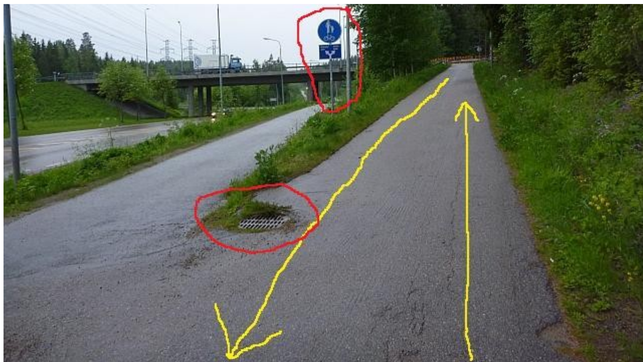
Reittikuva 85. Osuus päättyy Keltinmäentielle nousevaan luiskaan. Kuvan keskellä on montulla oleva kaivonkansi. Viitta on melko kaukana risteyksen jälkeen, joten ennen risteystä opaste ei erotu kunnolla.
