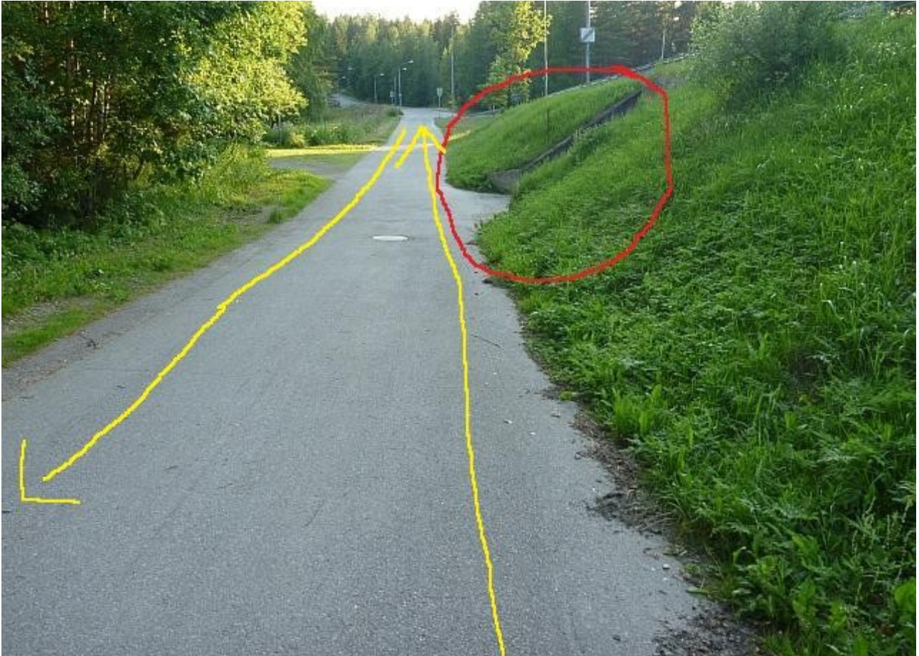
Reittikuva 65. Näkemäongelma ei juuri ole vähäisempi toisenkaan Keltinmäentien alittavan tunnelin luona. Huomaa myös, että tunnelimontun seurauksena kevytväylä on profiililtaan selvästi viereistä autotietä mäkisempi.
