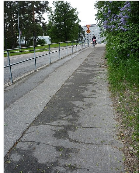
Reittikuva 19. Osuuden alusta asfaltti on railoista ja epätasaista 100 metrin matkalta. Väli pitäisi asfaltoida uudelleen mahdollisimman pian.
