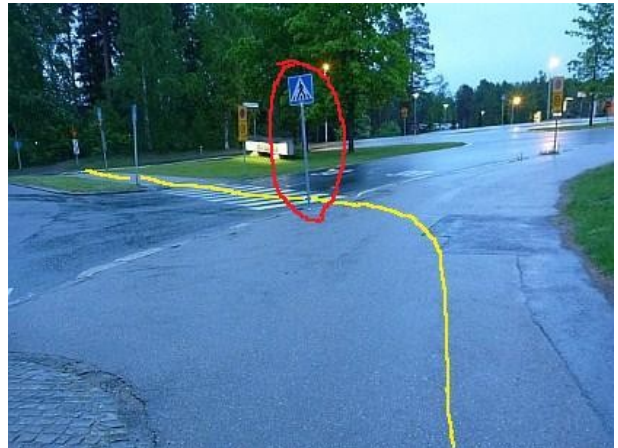
Liikennemerkki ajolinjalla aivan kevytväylän reunassa. Leveän tangon kanssa ajettaessa suuri osa Hoitajantien suojatiestä ja sen reunaluiskasta on poissa käytöstä.
