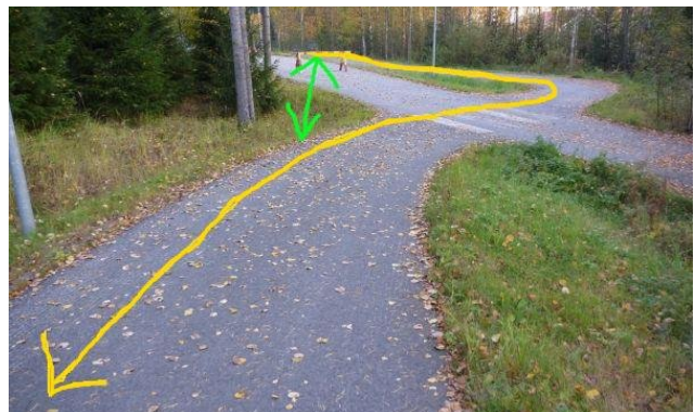
Reittikuva 43. Terttumäentien liittymä on poistunut käytöstä, joten kevytväyläkin pitäisi oikaista. Mutkassa kallistus on ulkokaarteeseen, ja kohtaan tullaan Puuppolan suunnasta kovaa vauhtia.
