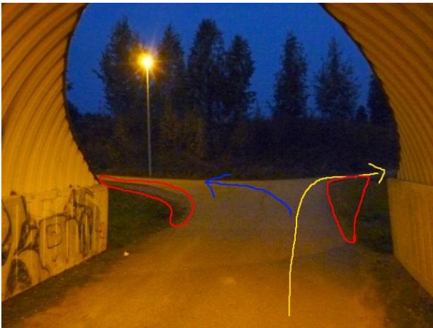
Reittikuva 29. Näkymä Ruokkeentien alittavan tunnelin suuaukolta. Läntinen pääreitti kääntyy oikealle ja myöhemmin esiteltävä Ruokkeentien täydentävä reitti vasemmalle. Kulmauksista puuttuu asfalttia, joten moni oikoo pientareiden puolelta.
