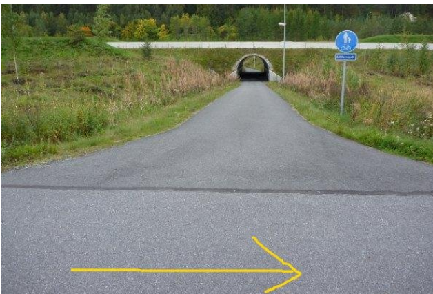
Reittikuva 62. Kaijalanniemen liittymä Saarijärventielle on muotoiltu oivallisesti.
