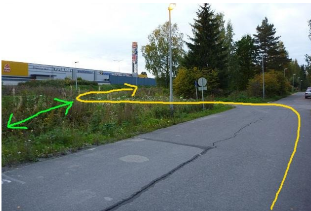
Kaksi risteystä ja kaksi epäjatkuvuuskohtaa Jokelan asuinalueen kupeella. Väylä mutkittelee tarpeettomasti, eikä opasteita ole.
