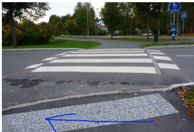
Reittikuva 113. Korotettu suojatie Rovastinpolulle on vaikea, lastissa lähes mahdoton, pyöräiltävä.
