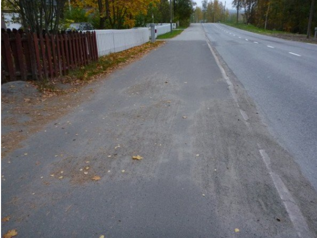
Reittikuva 20. Moottoritien liittymän luona tonttiliittymästä valuu hiekkaa.
