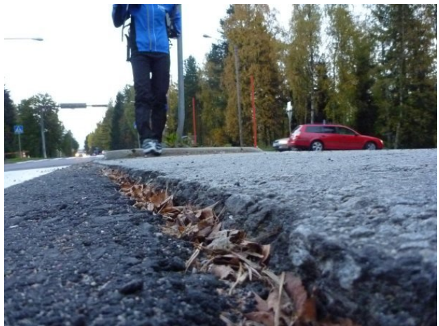
Reittikuva 122. Suojatiellä Rovastintien kevytväylälle on erittäin terävä asfaltin reunus. Ajoradan kautta pyöräileminen on mielekkäin vaihtoehto.
