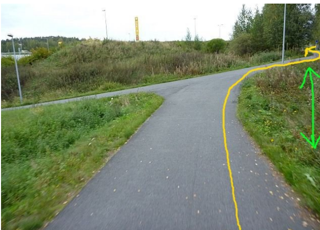
Tarpeeton mutka ja notkelma Palokankeskuksen tunnelin edustalla itäisellä pääreitillä. Kohtaan pitäisi rakentaa suuntaisliittymä.
