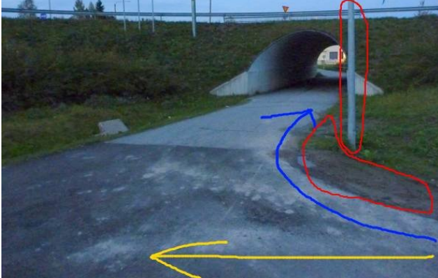
Reittikuva 105. Läntinen pääreitti jatkuu suoraan ja täydentävä reitti kääntyy oikealle. Mutkassa on asfalttia liian kapeasti ja tolppa ajolinjalla.
