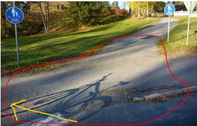
Matinmäentien ja Ollilantien risteyksessä kevytväylä Ollintielle on surkeassa kunnossa.
