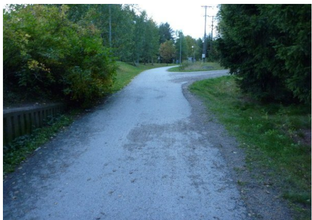
Reittikuva 118. Tunnelilta alkaen väylällä on runsaasti soraa. Sora valuu liittyvältä sorapintaiselta kevytväylältä.
