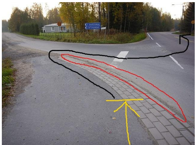
Reittikuva 46. Läntinen pääreitti päättyy Lintukankaantien risteykseen. Kevytwäylältä ei ole Puuppolantien ajoradalle mielekäästä pyöräilyreittiä, ja kevytwäylän kärjessä on myös runsaasti irtosoraa. Kohta on vaarallinen. Autoilijakaan ei pysty ennustamaan pyöräilijän ajoreittiä.
