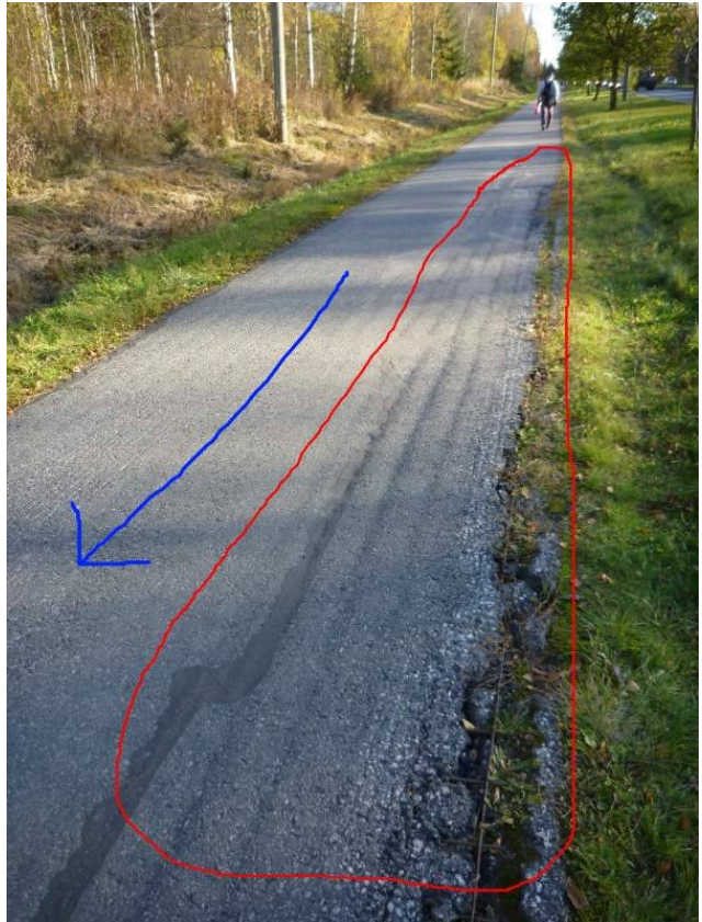
Reittikuva 126. Väylän pohjaraudoitukset ovat revenneet esille Palokanorren risteyksen lähellä.
