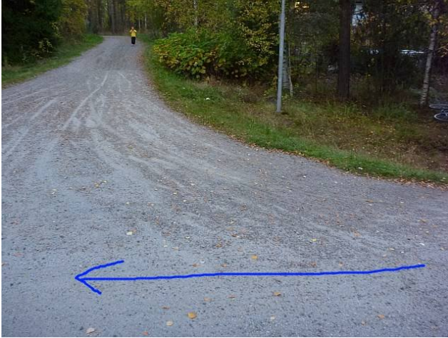
Reittikuva 119. Liittyvältä väylältä tulee soraa todella runsaasti. Asfaltin päällä irtosora aiheuttaa vaaratilanteita.
