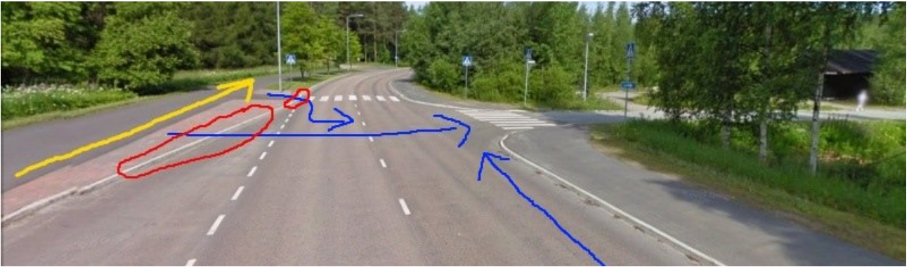
Reittikuva 12. Reivikujalle ei ole toimivaa pyöräilyreittiä, vaikka Reivikuja on toistaiseksi ainut kunnollinen väylä moottoritien itäpuoliselle laadukkaalle kevytväylälle. Parhaalla suoralla ajolinjalla on pystysuora reunatuki. Suojatiet ja jalkakäytävät on tarkoitettu vain jalankulkijoille. Kuva on toteutettu Google Street View -näkömön pohjalta.
