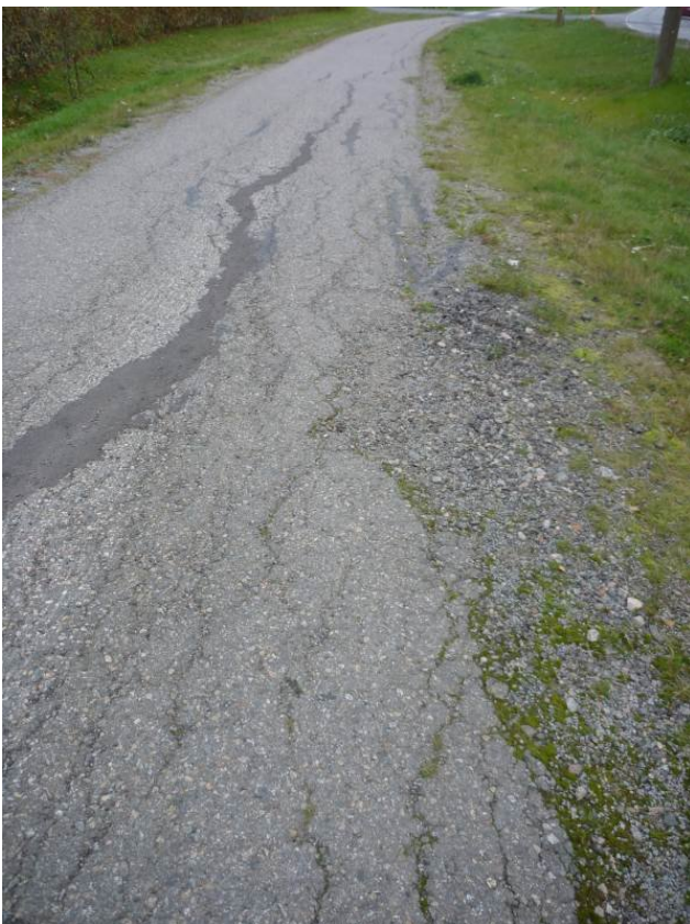
Railoja ja muita vaurioita Saarenmaantiellä Toukotien ja Nuutinkorventien välillä.
