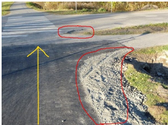
Reittikuva 86. Martikaisentien risteyksessä asfaltoitiin syksyllä 2010 melko huolimattomasti. Kulmaus voisi olla asfaltoitu laajemmin. Suojatien kärjessä on vaarallinen monttu.
