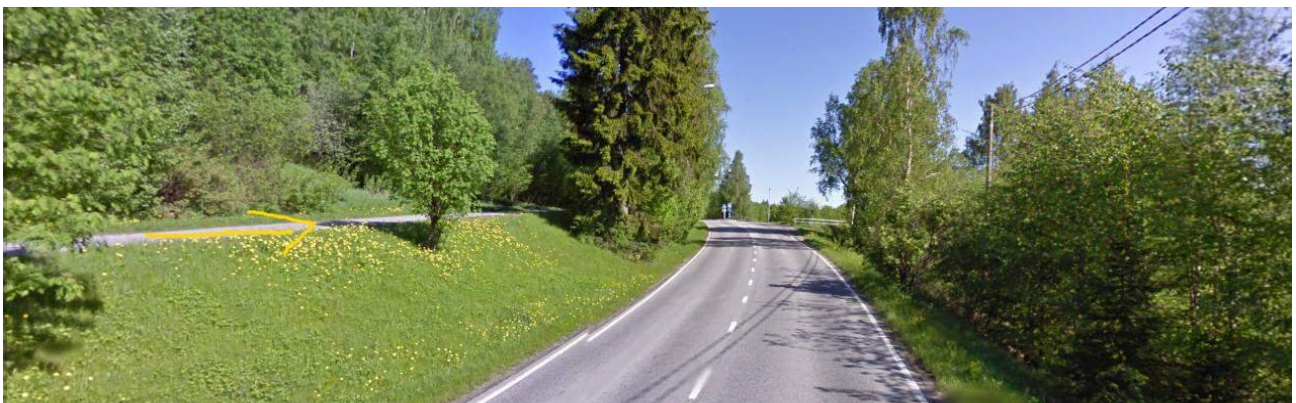
Reittikuva 22. Kevyväylän ja autotien korkeusprofiilit eroavat selvästi ennen Kajjalanniemen liittymää. Puut estävät autotieltä tulevaa valaistusta. Kuva on toteutettu Google Street View -näkömön pohjalta.
