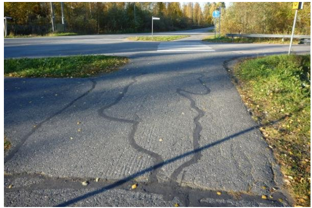
Reittikuva 89. Heikkiläntien risteyksessä on melko runsaasti railoja. Kääntyminen vasemmalle Alvajärventien suojatielle on liian jyrkkä.
