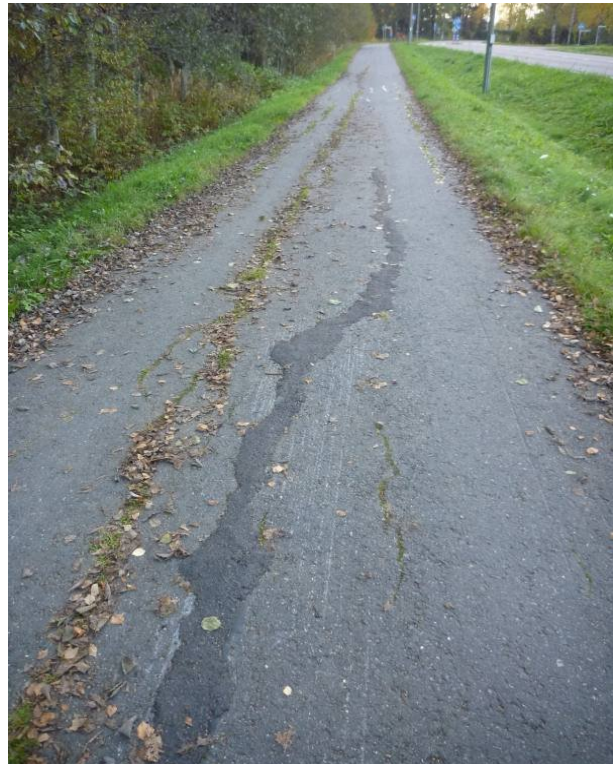
Reittikuva 39. Eerolantien ja Koppalantien välillä asfaltti on railoontunutta. Kevyväylä on hieman autotietä alempana.
