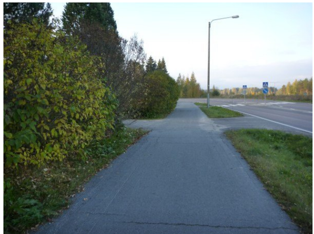
Reittikuva 36. Alvajärven alikulkutunnelin ja Kirrintien välillä väylällä on useita pahasti näkemäongelmaisia tonttiliittymiä. Pensasaita kaventaa kevytväylää merkittävästi.
