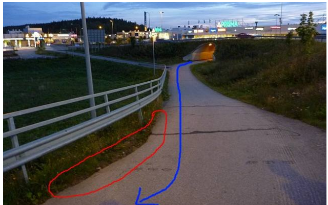
Reittikuva 108. Moottoritien ylittävän sillan reunus on revennyt ja repeämässä lisää. Tunnelille saa sillalta kovan vauhdin.
