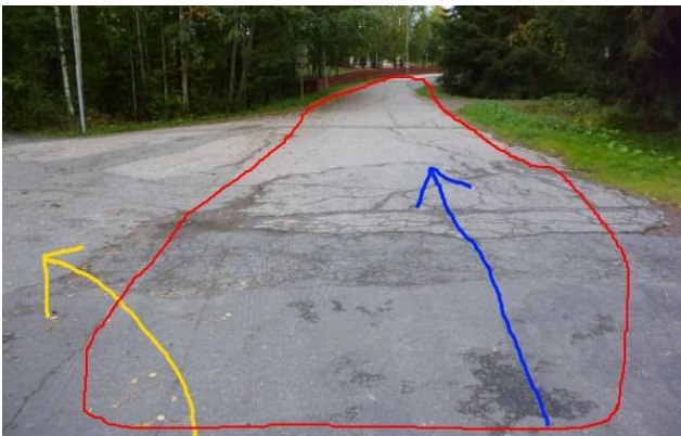
Reittikuva 110. Alun aukiolla asfaltissa on runsaasti vaurioita.
