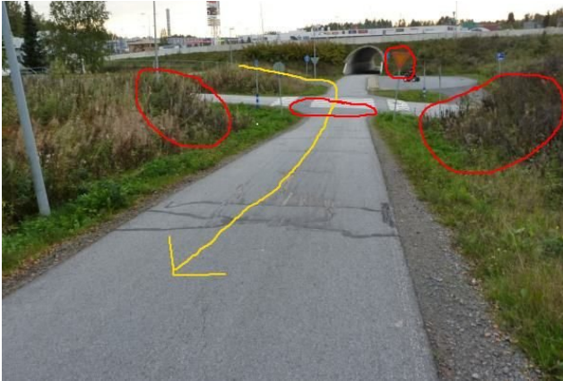
Palokanorren ja Jokelantien risteys. Palokan keskustan suunnasta tultaessa kulmissa on näkemäongelmat. Korotettu suojatie on muotoiltu hieman kulmikkaasti. Suomessa ei ole vielä ollut rohkeutta tehdä kevytväylistä etuajo-oikeutettuja.
