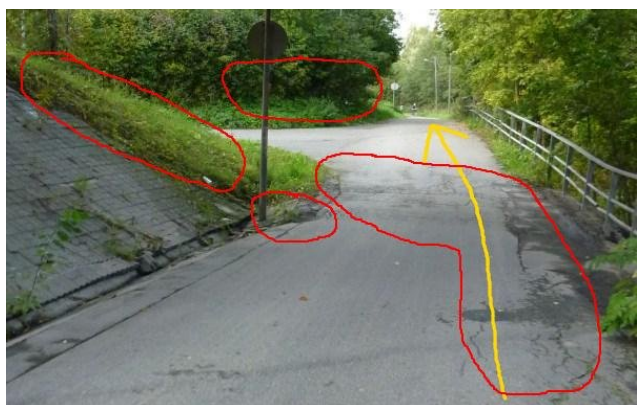
Reittikuva 49. Kaksi näkemäongelmaa ja asfaltin vaurioita Lohikoskentien tunnelin luona.
