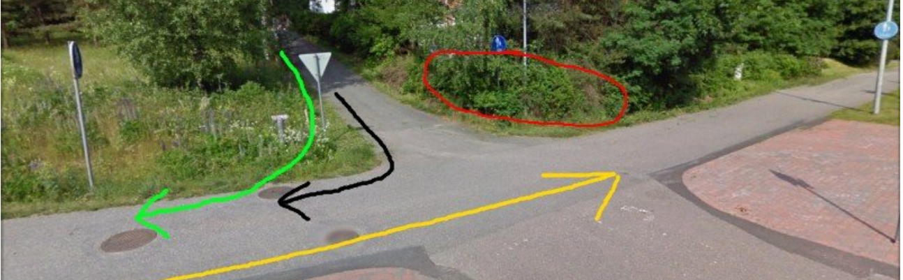
Reittikuva 9. Hongikontielle vievän kevytväylän liittymä on muotoiltu jyrkän 90-asteiseksi. Vaikeasti noudatettava ajolinja keskustan suuntaan on merkitty mustalla. Tilaa selvästi olisi vihreällä merkitylle loivemmallekin linjaukselle. Näkemäongelma on ympyröity. Kuva on toteutettu Google Street View -näkyvän pohjalta.
