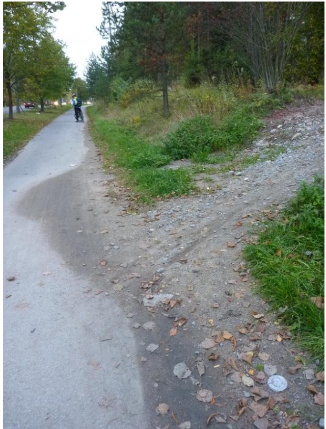
Polulta valuu runsaasti hiekkaa ja soraa Palokan keskustan täydentävällä reitillä Ritopohjantiellä.
