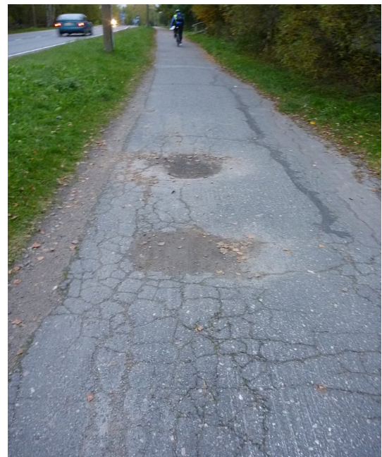
Ritopohjantien ja Matinmäentien kevytväylän käytettävyys on heikko erityisesti lukuisten asfalttivaurioiden vuoksi.
