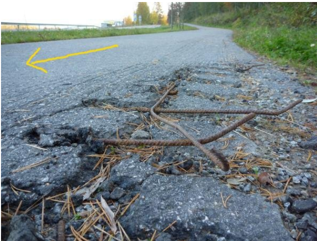
Reittikuva 35. Alvajärven kärjen kohdalla kevytväylän pohjaraudoituksia on vaarallisesti esillä.
