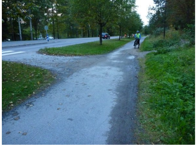
Reittikuva 120. Noin 150 metrin päässä Ritopohjantien tunnelilta liittyvältä polulta valuu runsaasti hiekkaa. Väylä on liian kapea.
