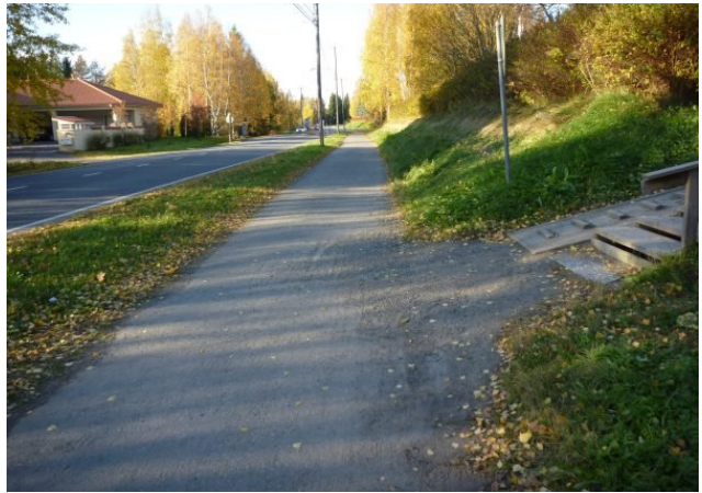
Reittikuva 79. Notkotien hiekkapintaiselta kevytväylältä valuu runsaasti hiekkaa. Väylä on kapeahko.
