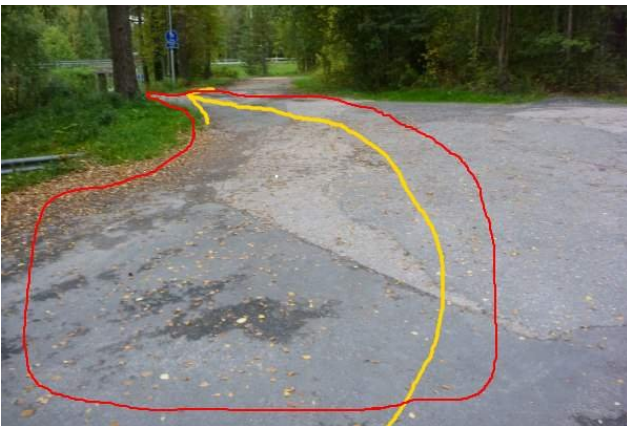
Reittikuva 71. Alun aukiolla asfaltti on huonokuntoista, eikä oikea reitti löydy helposti.
