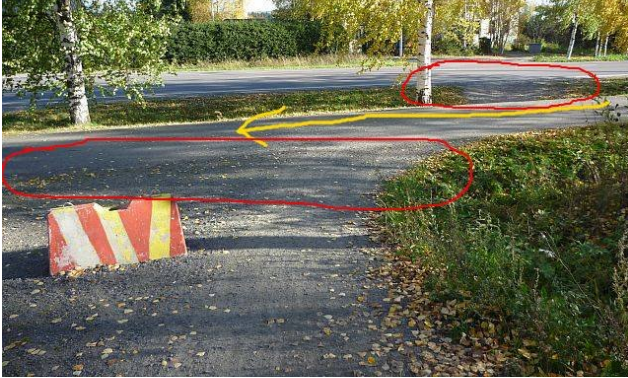
Kankaanpäänpolulta valuu hiekkaa Saarijärventielle. Laurilankujan suuntaan on puolestaan tamppautunut leveä polku.
