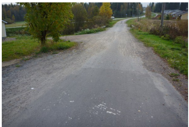
Reittikuva 100. Kankaanpäätien risteuksen jälkeen väylälle kerääntyy runsaasti hiekkaa.
