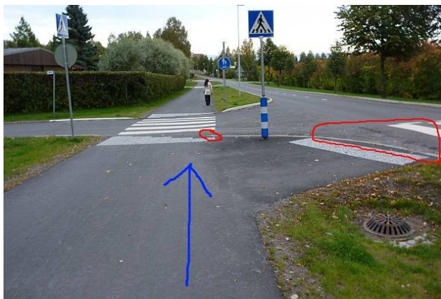
Reittikuva 112. Tuulikintien risteyksessä pystysuora reunatuki ulottuu väylän puolelle.
