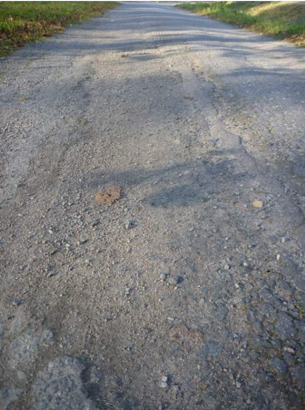
Reittikuva 125. Asfalttivaurioita Pappilanvuorentien ja Palokanorren välillä.
