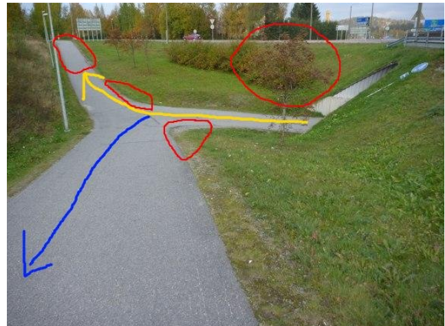
Reittikuva 30. Ruokkeentien tunneli kuvattuna Ruokkeentien täydentävän reitin puolelta. Tunnelin jälkeen on molempiin suuntiin jyrkät mäet. Vasemmassa yläkulmassa on ympyröity pinta- ja rakenneongelman alue.
