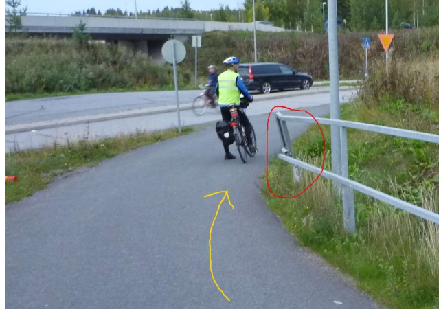
Kaiteen kärki on kiinni kevytväylän reunassa itäisellä pääreitillä Palokanorren risteyksessä. Koko väylän leveyttä ei voi käyttää.
