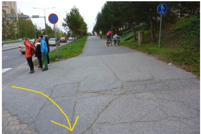
Reittikuva 8. Asfaltin vaurioita Lohikoskentien ja Taulumäentien kulmauksessa.
