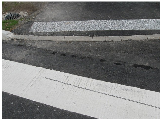
Huomiolaatta ja reunatuki Palokan keskustan täydentävällä reitillä Rovastintien ja Airanteentien risteyksessä. Suojatien ja reunatuen asfaltoinnin välissä on monttu.
