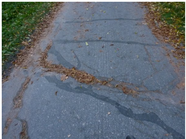
Reittikuva 77. Matinmäentielle tyypillistä väylää Oluttuvan piha-alueen jälkeen. Reunat ovat epäselvät, ja asfaltti on karkeaa, railoista ja töyssyistä.
