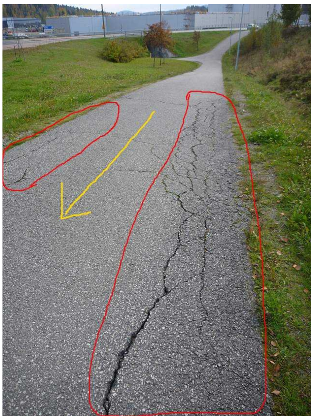
Reittikuva 31. Väylän runko on pettänyt melko pahasti Ruokkeentien tunnelin jälkeisessä mäessä. Vain puolet väylän leveydestä on käytössä. Tunnelille saa tästä mäestä todella kovan vauhdin.
