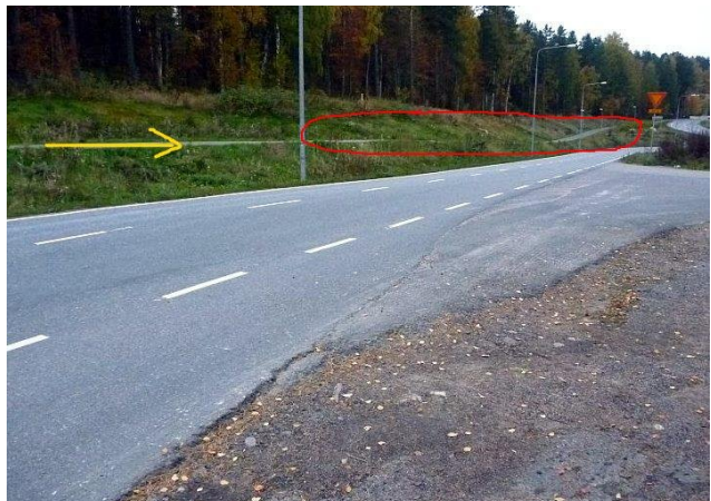
Reittikuva 19. Väylällä on tarpeeton notkelma Liinaharjunkadun kohdalta alkaen.
