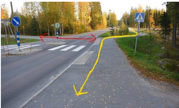
Reittikuva 42. Hietikkotien luona väylä mutkittaa tarpeettomasti. Hietikkotielle ei ole kävely- tai pyöräilyreittiä. Suojatie johtaa vain bussipysäkille.
