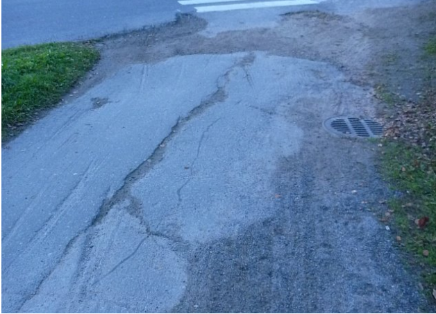
Reittikuva 81. Väylän kuntoa Ollilantien risteyksessä.
