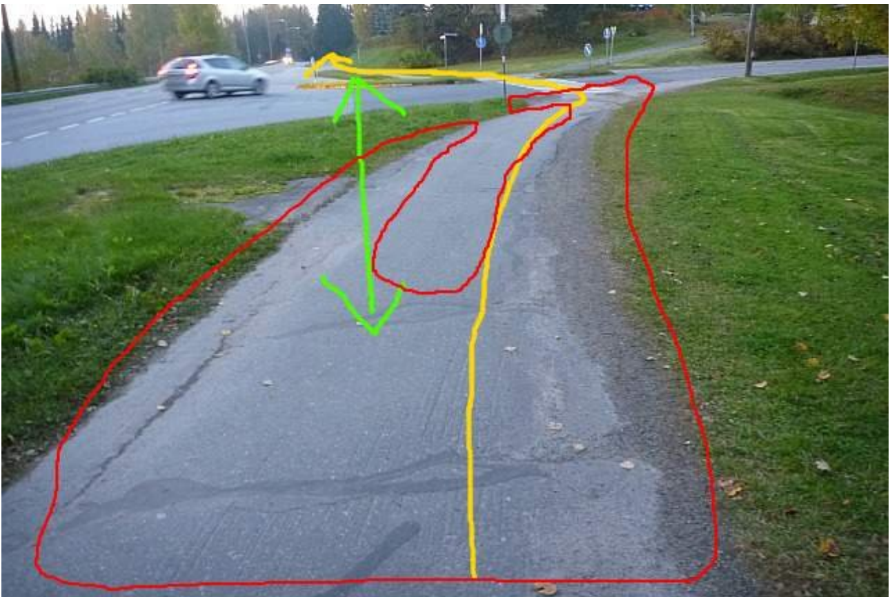
Reittikuva 80. Ollilantien risteyksessä ajolinja mutkittelee ja asfaltti on surkeassa kunnossa.
