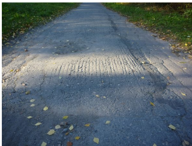
Reittikuva 128. Töyssyistä asfalttia Tapionkujan risteuksen luona.
