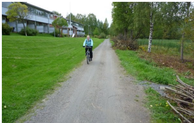
Reitokuva 57. Hiekkapintaista väylää osuuden lopussa. Valaistusta ei ole.
