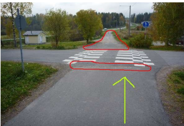
Reittikuva 99. Kankaanpäätien risteyksessä korotettu suojiatie on muotoiltu turhan jyrkkäreunaisesti. Risteuksen jälkeen väylällä on notkelma, ja väylälle kerääntyy hiekkaa.
