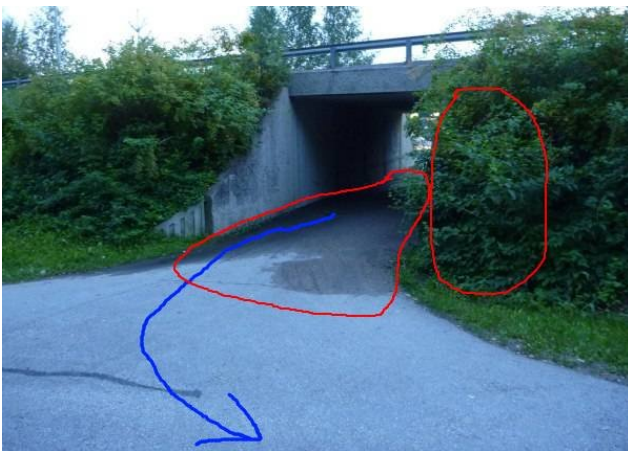
Ritopohjantien alikulku Palokan keskustan täydentävällä reitillä. Tunnelin pohjalla on vielä runsaasti hiekkaa.
