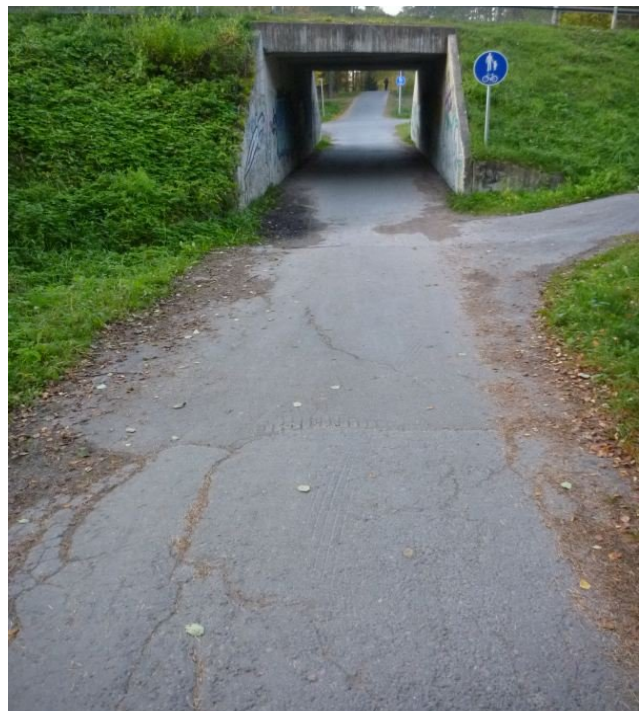
Reittikuva 72. Palokanorren tunneli on ahdas. Heti tunnelin jälkeen on hankala nelisuuntainen risteys.
