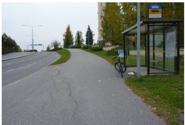
Reittikuva 5. Lohikoskentiellä on vinoittainen töyssy, jonka keskelle on halkeillut raitiovaunut. Kevytväylä on hieman autotietä mäkisempi.
