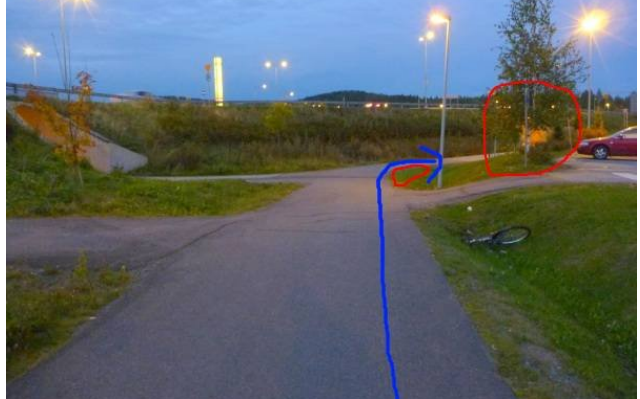
Reittikuva 106. Vasemmalla väylät pysäkillä ja Laurilankujalta. Mutka Sammontien tunnelille on liian jyrkkä ja kulmassa on puita näkemäesteenä.
