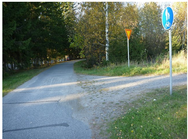
Reittikuva 84. Ollintien kärjestä tulevalta kevytväylältä valuu hiekkaa. Reunasta puuttuu asfalttia. Kuusiaita estää täysin autotieltä tulevan valaistuksen.
