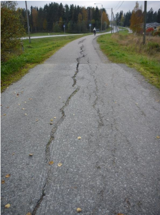
Reittikuva 101. Saarenmaantien kevytväylän alussa on vaarallisia railoja.
