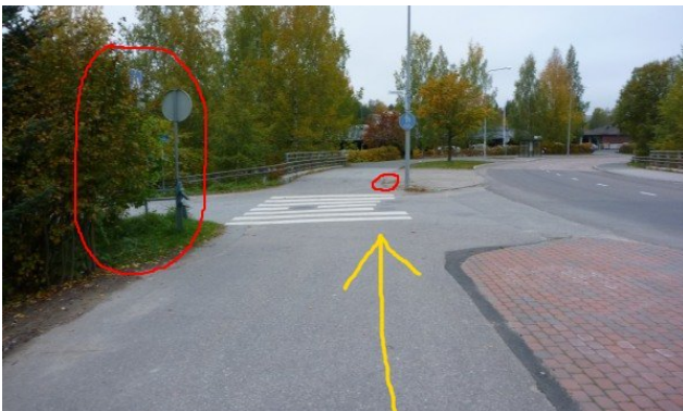
Reittikuva 10. Taulupolun risteyksessä on näkemäongelma. Suojatien jälkeen väylän reunassa on monttu.
