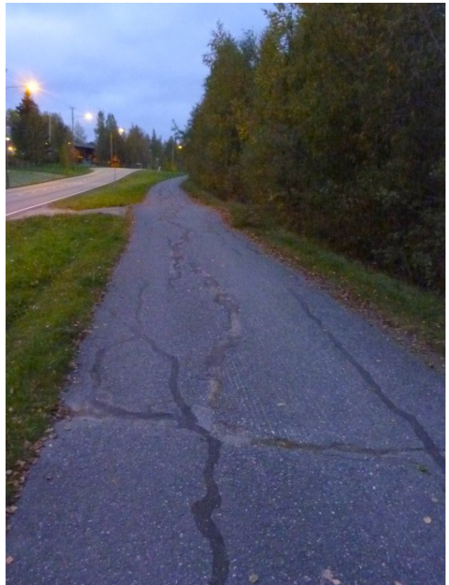
Reittikuva 88. Matikaisentien ja Heikkiläntien välillä asfaltti on railoista ja karkeaa.
