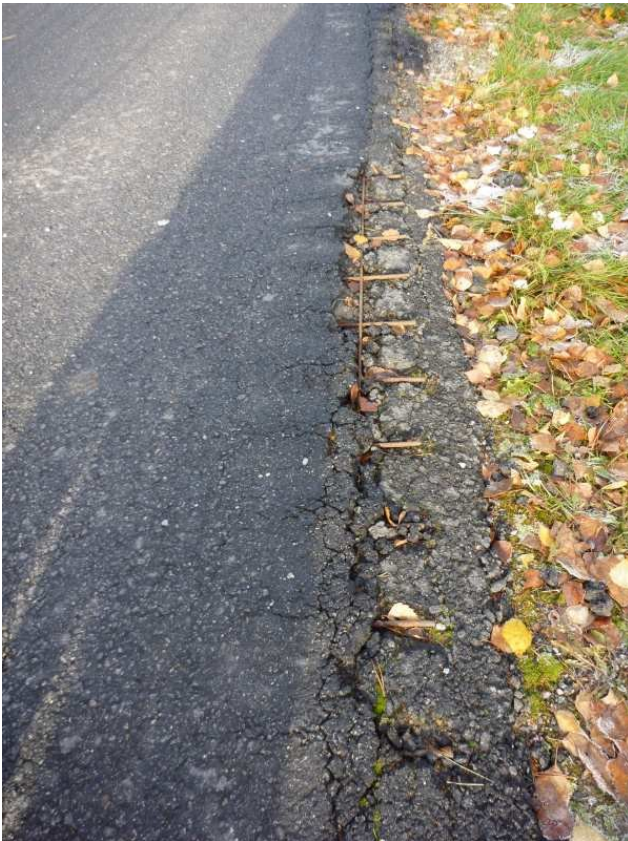
Pohjaraudoituksia esillä Saarijärventiellä Ruokkeentien ja Haukkamäentien välillä.
