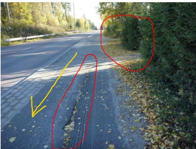
Reittikuva 45. Puuppolantiellä on useita hankalasti näkemäongelmaisia tonttiliittymiä. Asfaltissa on leveä pitkittäisrailo.
