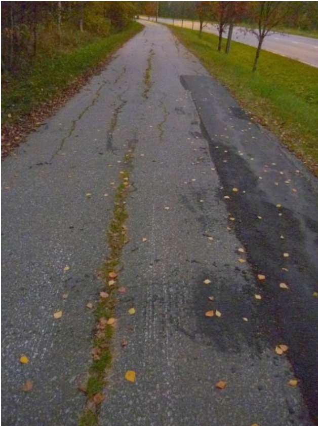
Reittikuva 23. Kaijalanniemen liittymän jälkeen väylä pitäisi kunnostaa pikaisesti kauttaaltaan.
