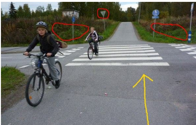
Reittikuva 69. Jokelantien risteys on selkeä ja suora. Kulmauksissa on näkemäongelmat. Kevyväylällä on kolmiot.
