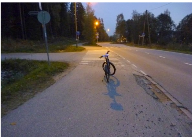
Reittikuva 25. Osuus alkaa tämän liittymän jälkeen. Neljännän osuuden lopussa väylän reunasta puuttuu asfalttia.
