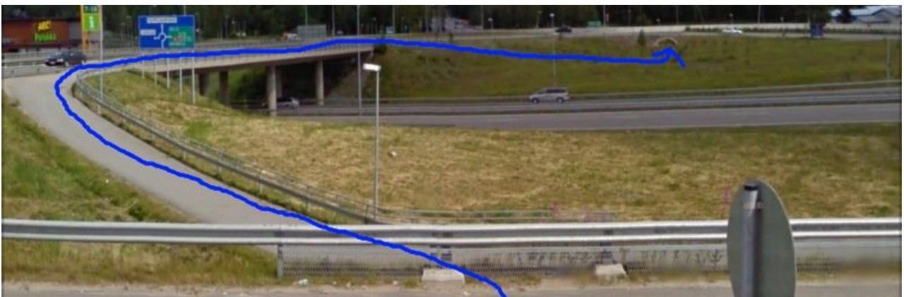
Reittikuva 109. Ajoreitti Sammontien tunnelilta liittymärampin tunnelille. Ainakaan raskaassa kauppalastissa reittiä ei tee mieli pyörällä. Kuva on toteutettu Google Street View -näkökuvan pohjalta.
