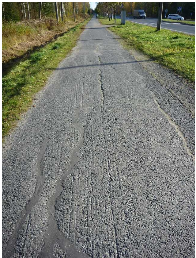
Karkeaa ja railoista asfalttia Ritopohjantiellä Palokanorren risteuksen lähellä.
