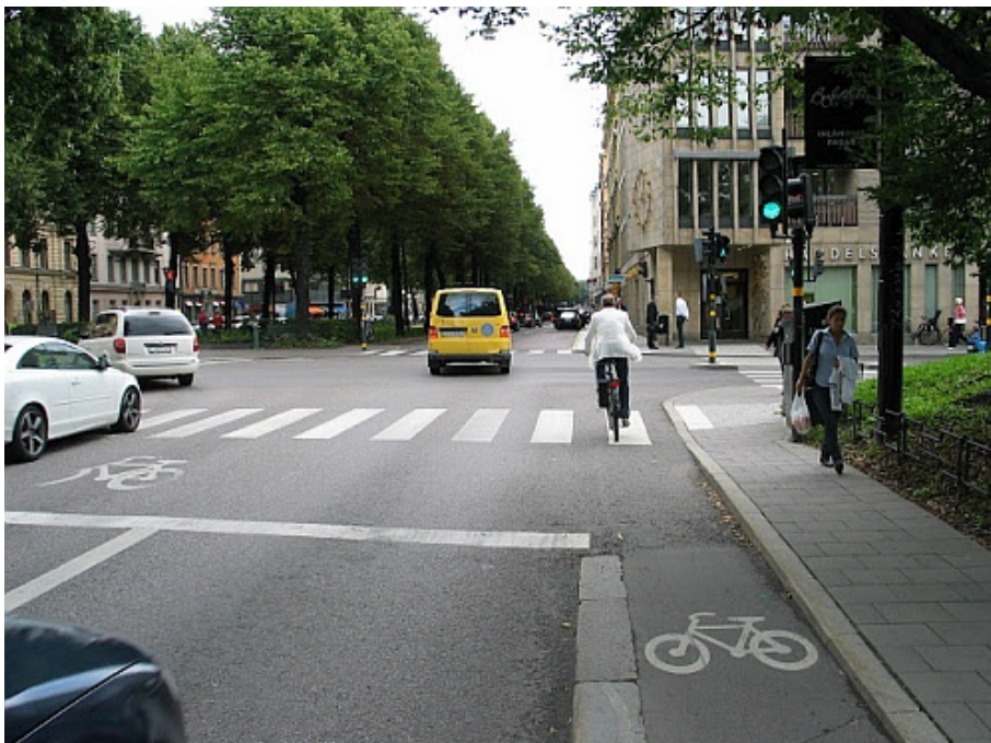
Tukholmasta otetussa kuvassa näkyy, kuinka yksisuuntainen pyörätie voidaan tarvittaessa toteuttaa tilaa säästäen. Vastaantuleviakaan ei tarvitse väistää. Kuvassa pyörätie laskeutuu risteyksen matkalta pyöräkaistaksi, johon on toteutettu vasemmalle kääntymistä helpottava pyörätasku
