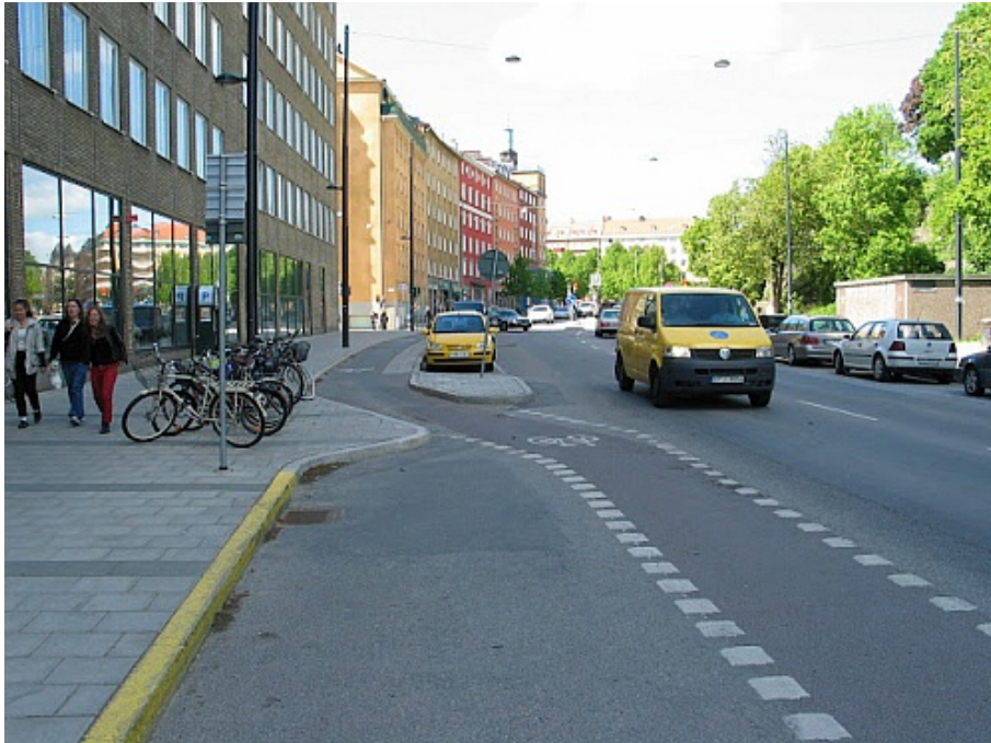
Kuva Tukholmasta näyttää, miten yksisuuntaisen pyörätien voi yhdistää jatkuvaksi väyläksi pyöräkaistan kanssa, kaksisuuntaisten pyöriteiden kanssa näin hyvät ratkaisut väylätyyppien yhdistelyssä eivät ole mahdollisia.
