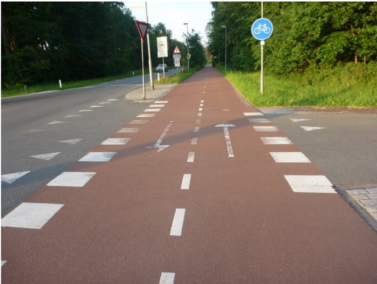
Esimerkillinen etuajo-oikeutetun pyörätien ja autotien risteys Hollannissa lähellä Bredaa. Etuajo-oikeuden lisäksi huomioitavaa sileä ja tasainen kaistoitettu pyörätie (kuva: Teemu Tenhunen).
