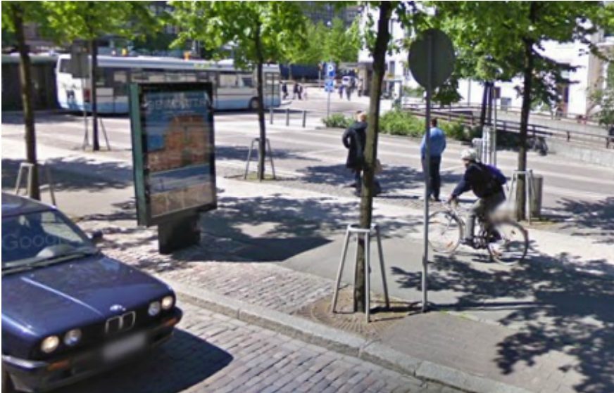
Helsingin Pohjoisesplanadilla aivan pyörätien viereen (tai jopa päälle) sijoitettu mainosteline on näkemäeste ja kaventaa pyörätien efektiivistä käytettävissä olevaa leveyttä huomattavasti.
