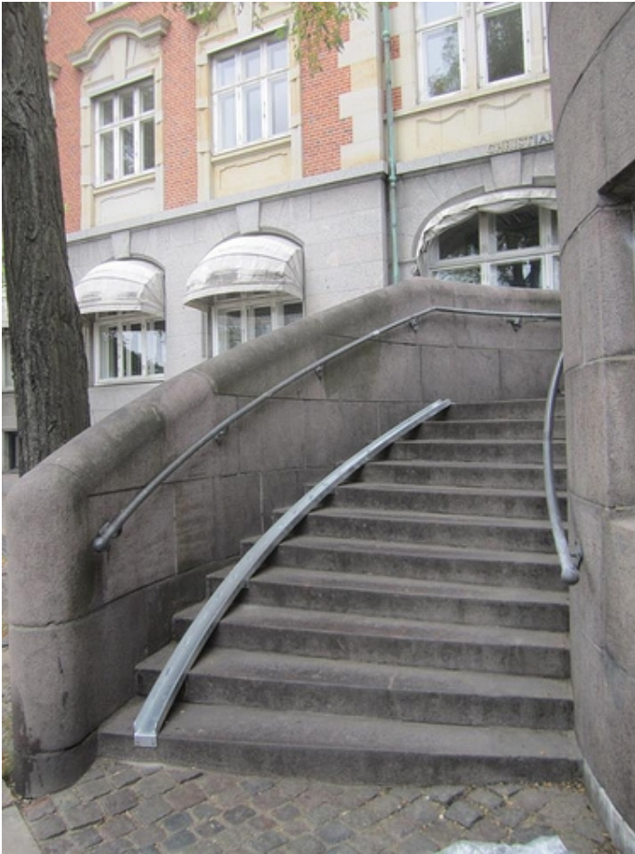
Pienet portaat pyöräilijän matkalla eivät haittaa, jos niissä on pyöräkouru. Tanskassa kouru voidaan tehdä kierreportaisiinkin (kuva: I bike CPH ).
