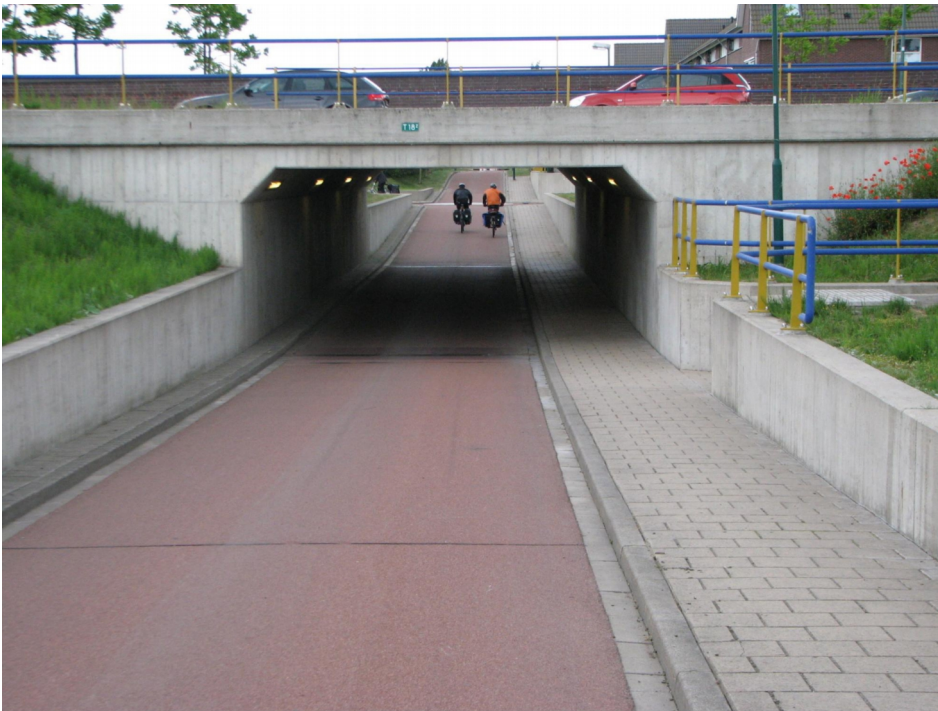
Hollannissa jalankulkijoita ja pyöräilijöitä ei pääsääntöisesti laiteta samaan alikulkuun. Jos laitetaan, niin selvästi rakenteellisesti eroteltuna. Erittäin käyttökelpoinen on myös kaksiaukkoinen alikulku, joka pitää eri liikennemuodot erillään.
