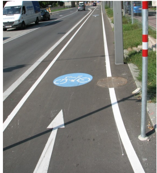
Malliesimerkki ajoratamerkinnöistä. Reunojen maalaaminen helpottaa pimeällä liikkumista. Huomaa myös heijastinteipit ensimmäisessä tolpassa.
