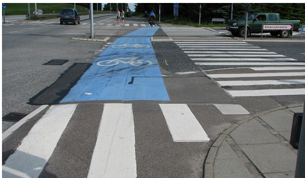
Risteyks Tanskassa: eroteltu pyörätie laskeutuu risteyksen ajaksi autotien tasalle.
