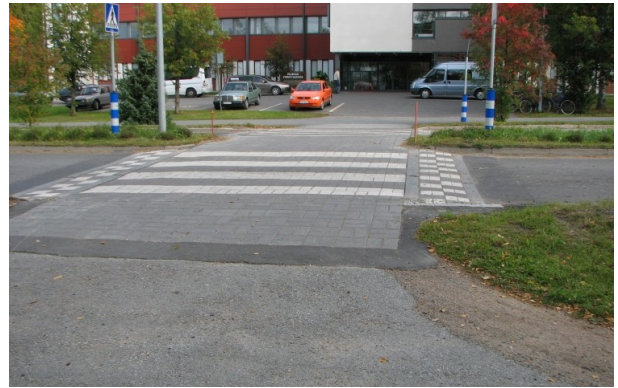
Onnistunut selkeä yhdysliittymä suunnitellulla laatukäytäväreitillä Palokan keskustassa.
