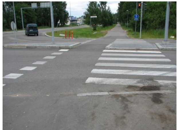
Eroteltu risteys, jossa pyörätie on toteutettu esimerkillisen suorana ja tasaisena.
