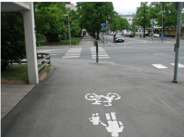
Matala, muun liikenteen takaa täysin näkymätön liikennevalotolppa vaarallisesti keskellä kevytväylää.
