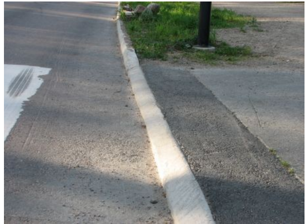
Tällaisia reunatukia on Suomessa aivan liikaa. Kiveyksen yli on lähes mahdoton ajaa pyörälaukkujen, peräkärrin, lastenistuimen tai muun raskaan lastin kanssa.
