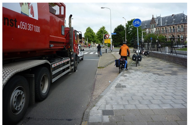
Kääntymiskaista ajoradan reunasta pyöräkaistalta pyörätielle. Näin pyöräilijän ei tarvitse jäädä odottamaan valojen vaihtumista.
