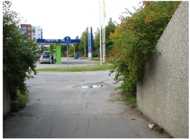
Tunnelin suuaukon naamiointit laatukäytäväreitillä Palokassa. Tunneli on vaarallinen.
