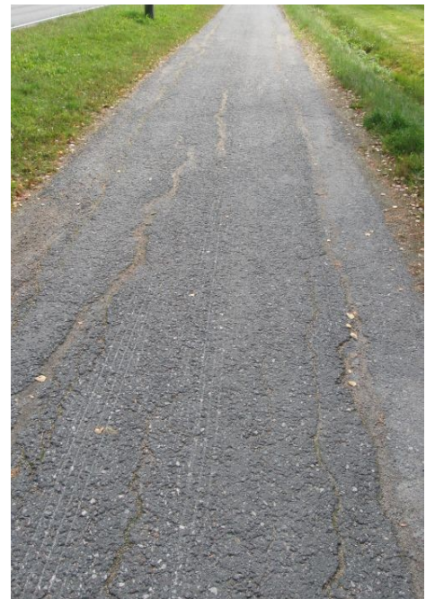
Railoja ja erittäin karheaa asfalttia suunnitellulla laatukäytäväreitillä lähellä Palokkaa.
