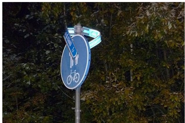
Vain toisesta päästään kiinnitettyjen viittojen ongelma: kyltit on väännetty mutkalle. Kuva on Valmetintieltä.
