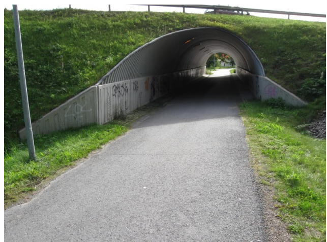
Oivallinen Lohikoskentien alittava tunneli suunnitellulla laatukäytäväreitillä. Tästä kannattaa ottaa mallia.
