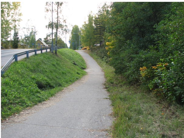
Tunnelin suuaukko sijaitsee montun pohjalla ja on piilotettu lähes täysin.
