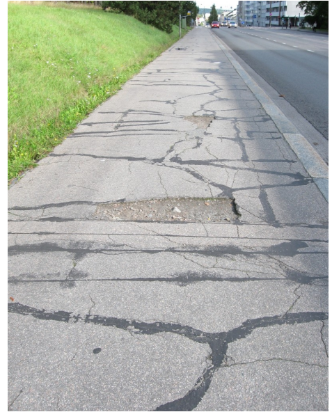
Railoja ja monttuja asfaltissa Yliopistonkadulla.
