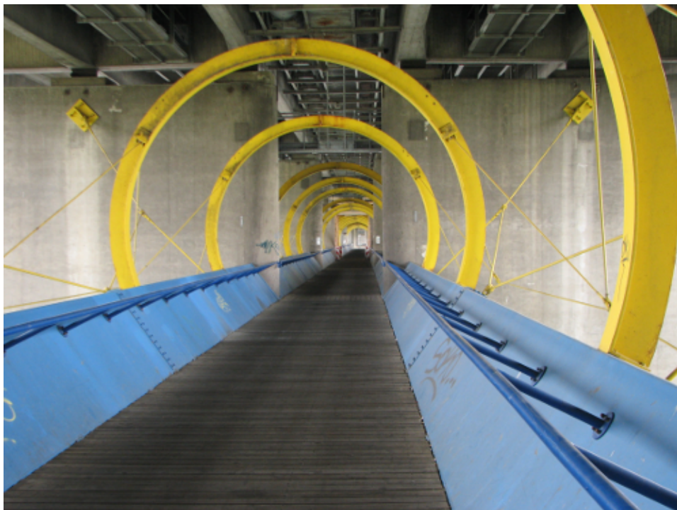
Kuva 36: Kevyttekoisempi kevyenliikenteen silta.
