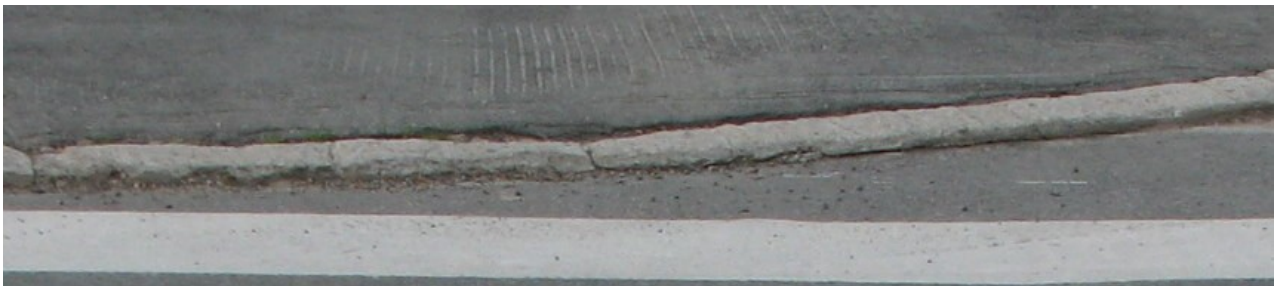
Valettu betonireunus. Tällaiset, pyöräilyä selvästi haittaavat ratkaisut ovat erittäin yleisiä.
