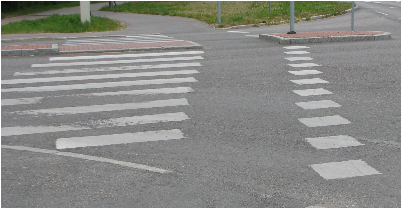
Melko toimiva eroteltu risteys. Jalkakäytävällä on reunakiveykset, pyörätiepuolella tasainen ja suora ajolinja.
