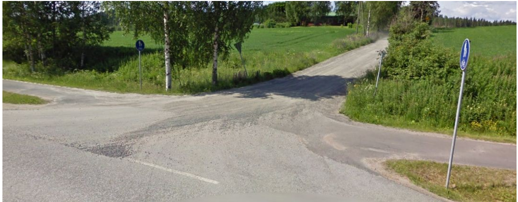
Kuva 3. Rannilantieltä valuu Puuppolantien kevytväylälle runsaasti hiekkaa ja soraa. Tähän ei ole turvallista ajaa kovin kovaa. Käytännössä risteys yleensä kierretään autotien kautta.
