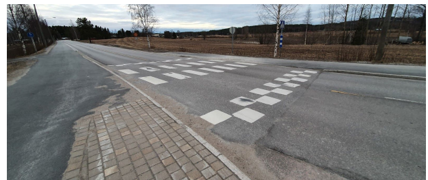
Korotettu suojatie / pyörätien jatke Vaajakoskentien yli on toteutettu todella huonosti. Kapearenkaisella pyörällä on miellyttävämpi ajaa korotuksen yli ajoradan suunnassa kuin pyörätieltä pyörätielle. Kohta pitäisi ehdottomasti kunnostaa ja muuttaa uuden TLL:n mukaiseksi pyörätien jatkeeksi.
